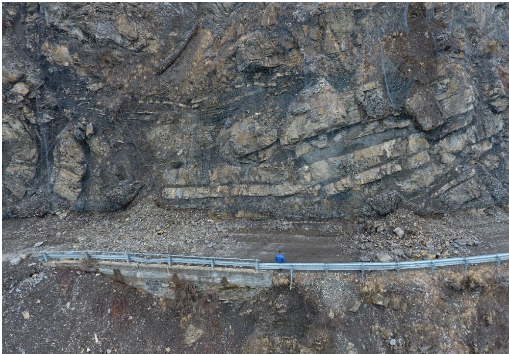
Fig. 13: frana di tipologia b) sulla sc Secchio – Deusi, Comune di Villa Minozzo, RE (foto G. Bertolini); due crolli dalla parete rocciosa a monte della viabilità che impongono un intervento di disaggio e ripristino delle reti di protezione.
