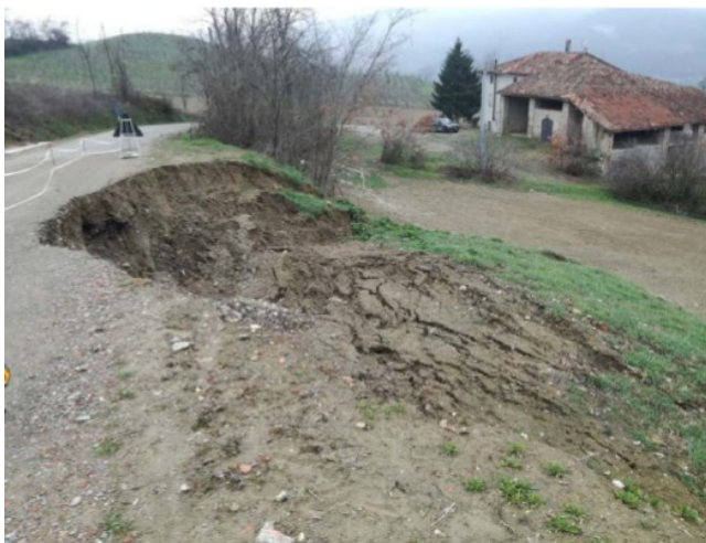
Fig. 13: frana di tipologia b) sulla sc Secchio – Deusi, Comune di Villa Minozzo, RE (foto G. Bertolini); due crolli dalla parete rocciosa a monte della viabilità che impongono un intervento di disaggio e ripristino delle reti di protezione.
