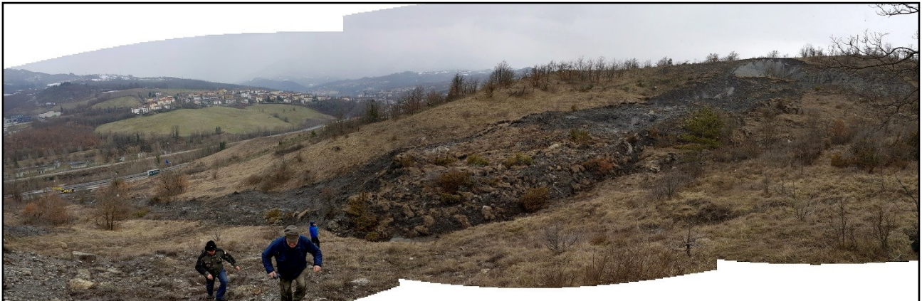
Fig. 7: frana per colamento, avvenuta dopo le precipitazioni di inizio febbraio in comune di Gaggio Montano (BO), località Silla, e che ha coinvolto la vecchia strada statale 68 Porrettana. Foto fornita dal Servizio Area Reno – Regione Emilia- Romagna.
