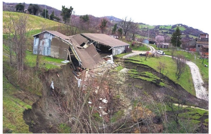
Fig. 18: a sinistra vista del piede, costituito dalla fluida colata di fango che si immette nel Fiume Marecchia (Foto C. Lucente); a destra particolare del capannone distrutto dallo scorrimento di fango e detrito (Foto da drone del volontariato di Protezione Civile - RER Servizio Area Romagna).
