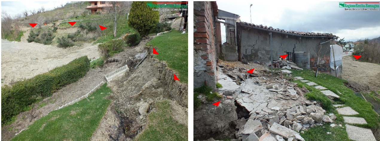
Fig. 23: danni nei pressi del coronamento (triangoli rossi) della frana di Rontagnano (Sogliano, FC).
