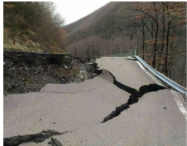
Fig. 13: frana di tipologia b) sulla sc Secchio – Deusi, Comune di Villa Minozzo, RE (foto G. Bertolini); due crolli dalla parete rocciosa a monte della viabilità che impongono un intervento di disaggio e ripristino delle reti di protezione.
