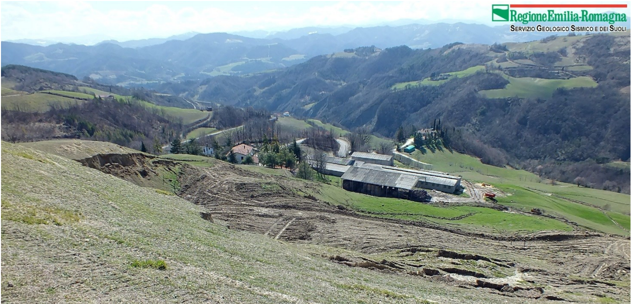
Fig.21: frana di Mezza Cà: vista del fienile, raggiunto e danneggiato dalla frana e, in secondo piano, della stalla immediatamente a valle, risparmiata dal movimento. La scarpata del coronamento è alta circa 4 metri.
