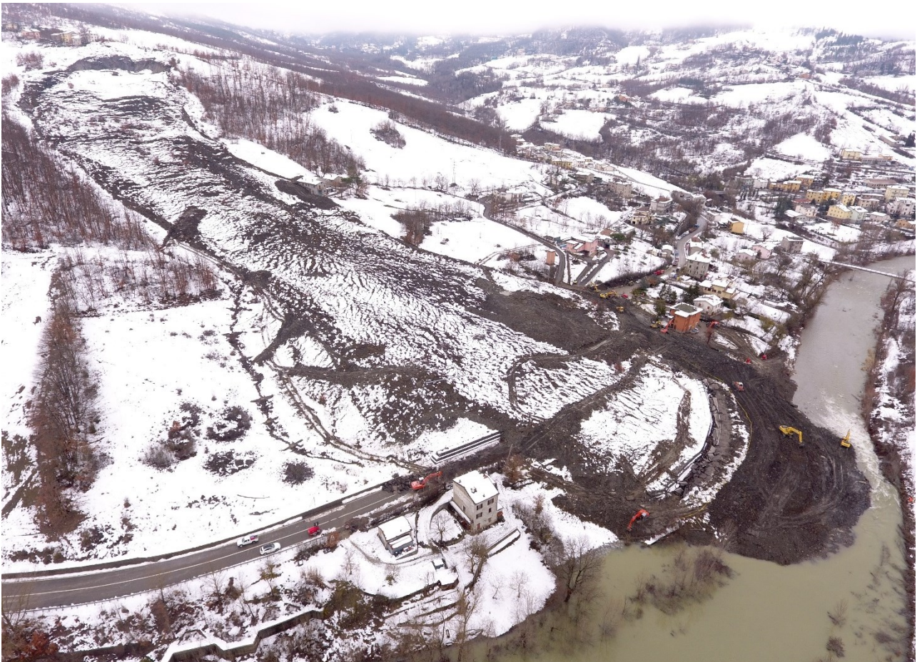
Fig. 19: la frana di Maranino (Gaggio Montano, BO). L'entità della traslazione, al piede della frana, della ex SS 65 Porrettana è di circa 40-50 m. Immagine da drone – Unione montana Alto Reno.
