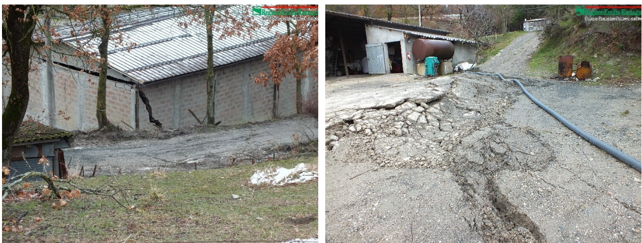
Fig. 29: particolari dei danni della frana in località Terzo (Bagno di Romagna, FC).
